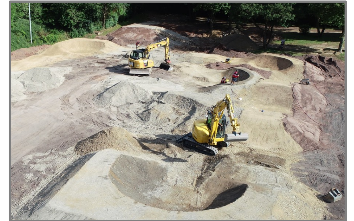
Erstellung einer Pumptrack-Anlage (Beispielszene)
