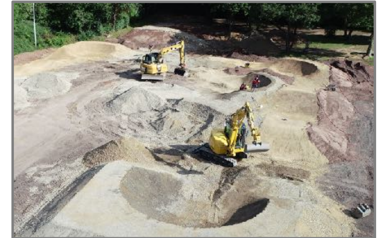
Erstellung einer Pumptrack-Anlage (Beispielszene)
